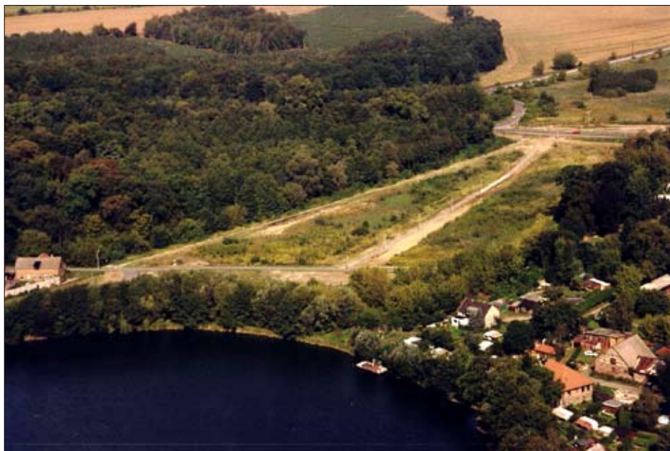
Luftaufnahme Oktober 1990 ehem. Grenzstreifen am Gutspark Groß Glienicke
