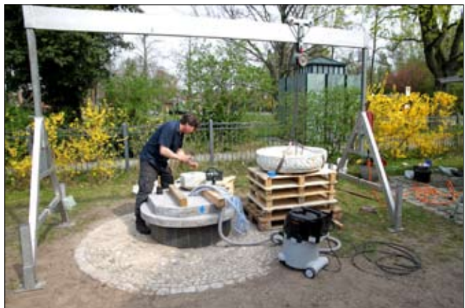
Der Restaurator Lutz Dölle beseitigt Kunstharz aus den Dübellöchern
