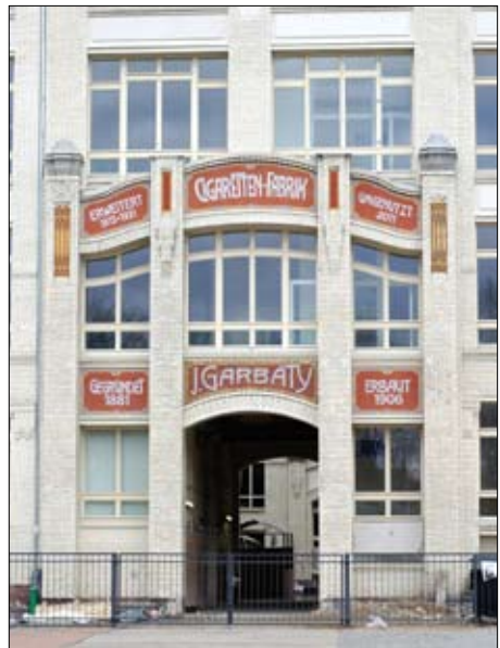
Portal der ehemaligen Zigarettenfabrik Garbáty, Zustand 2011 Quelle: Wikimedia, Steffen Zahn
