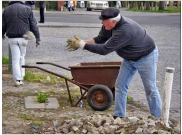
Horst Pessel beseitigt den vor unserem Haus abgekippten Haufen Pflastersteine 2007
