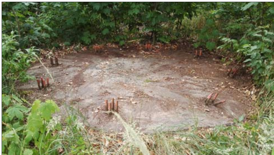
Die Bodenplatte des Feuerwachturms auf dem Luisenberg 2018
