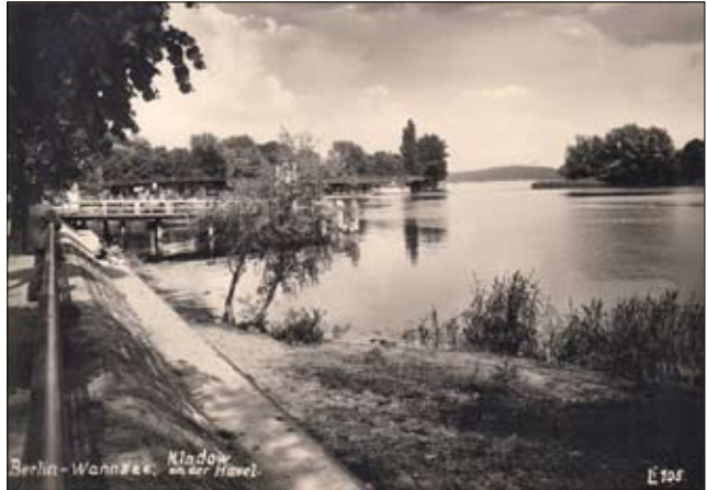
Die Rampe am Hafen in Kladow
