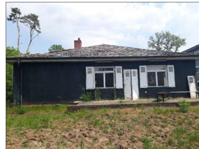
Das Kupferhaus auf dem Gelände der General-Steinhoff-Kaserne
