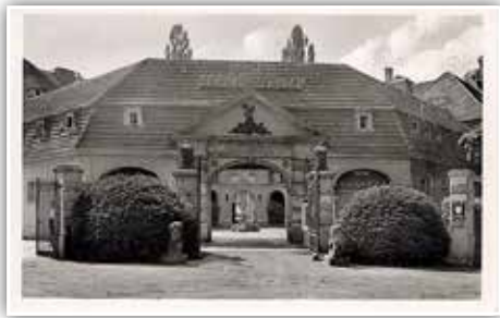
Schloss Brüningslinden, Haupteingang
