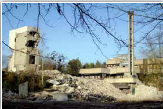
Der Abriss der Gebäude des DED ist in vollem Gange 2010
