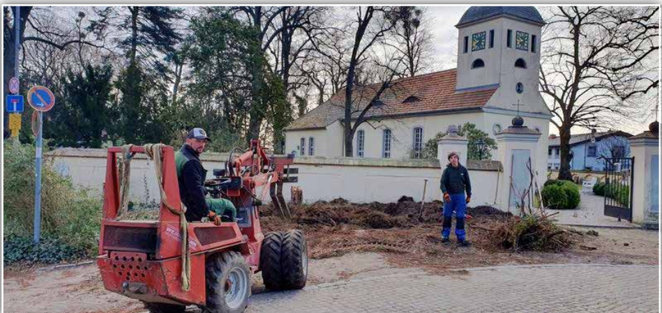
Die Arbeiten vor der Dorfkirche sind in vollem Gange
