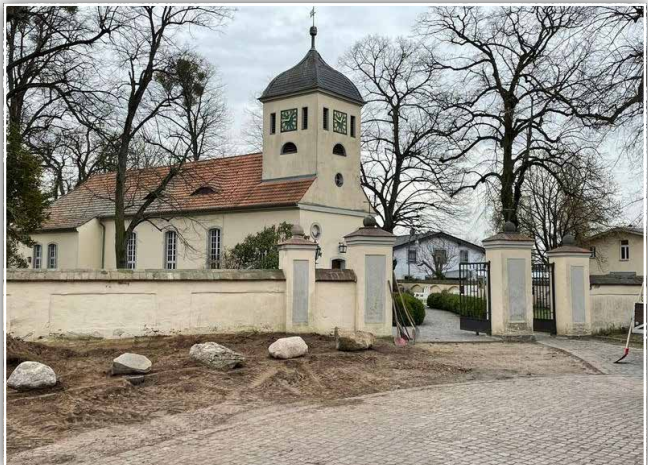
Die Arbeiten sind fast fertig
