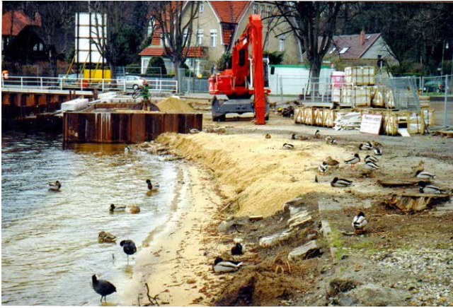
Umbau der Uferpromenade
