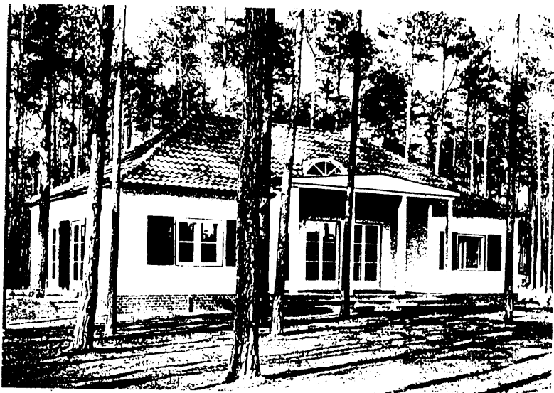
Bild links: Landhaus Mohr, Seebad Cladow- Groß-Glienicke 1930. 1929 als erstes Haus auf dem Gelände des parzellier- ten Gutes Groß- Glienicke in der heutigen Wald- allee erbaut.
