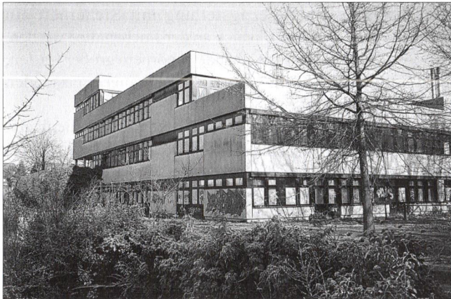
Abriss der Gebäude des ehem. Deutschen Entwicklungsdienstes am Kladower Damm 26.12.2009 Foto: Rainer Nitsch
