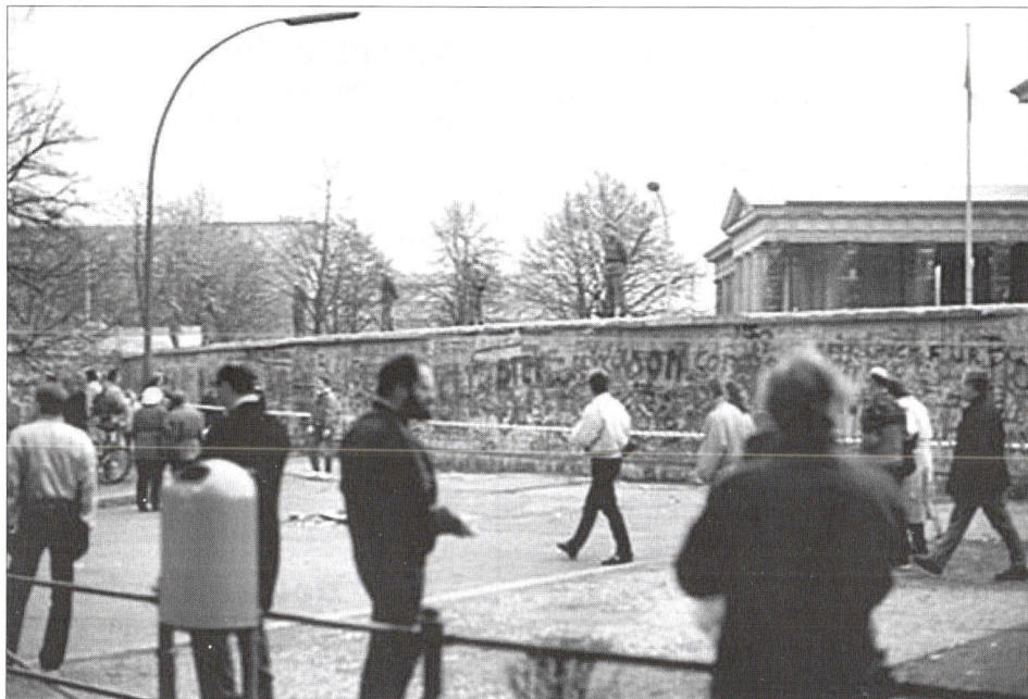
An der Mauer in Mitte. Ruhe vor dem Sturm? November 1989
