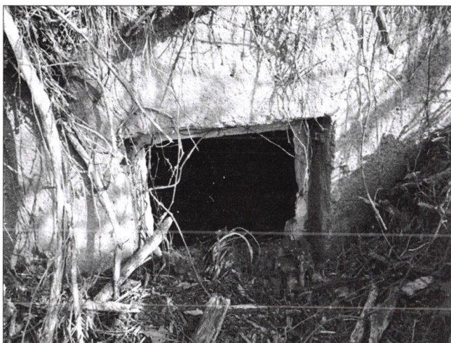
Mauerreste des ehemaligen Kellers
