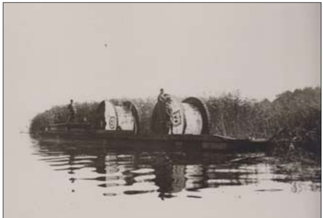
Prahm mit 2 Kabeltrommeln mit je 600 m 75paarigem Kabel bei der Verlegung von Wannsee nach Kladow
