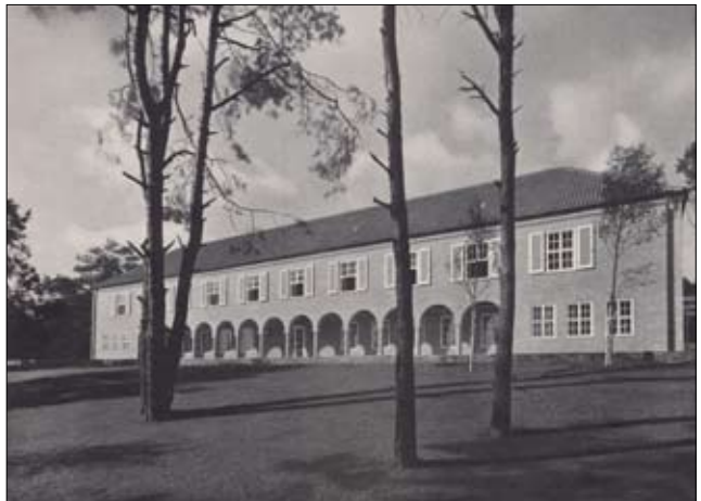
Hauptschauseite des Auslandshauses mit Bogengang
