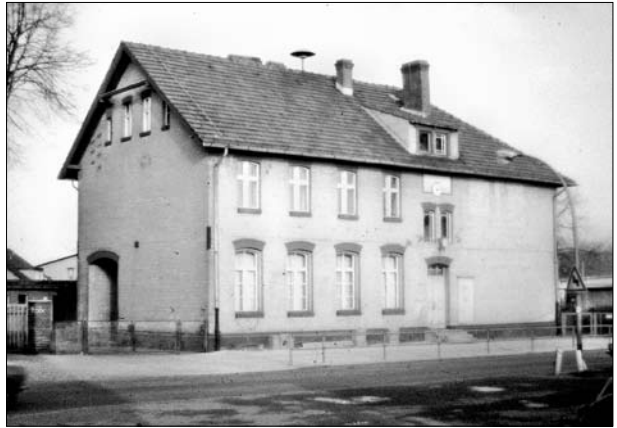
Foto 1: Die Dorfschule in der Sakrower Landstraße 2 mit der Sirene auf dem Dach Quelle: Helmut Bünning
