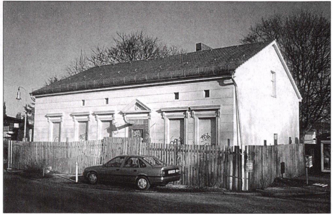
Bürgerhaus mit neuem Putz
