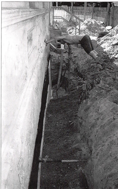
Das freigelegte Fundament
