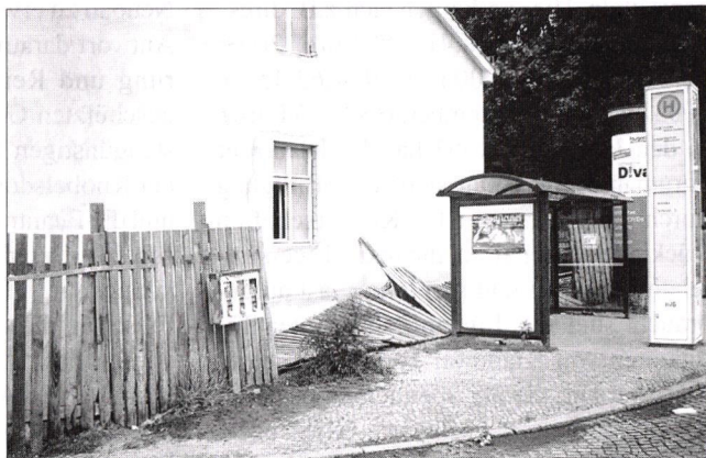
Vandalismus am Bauzaun
