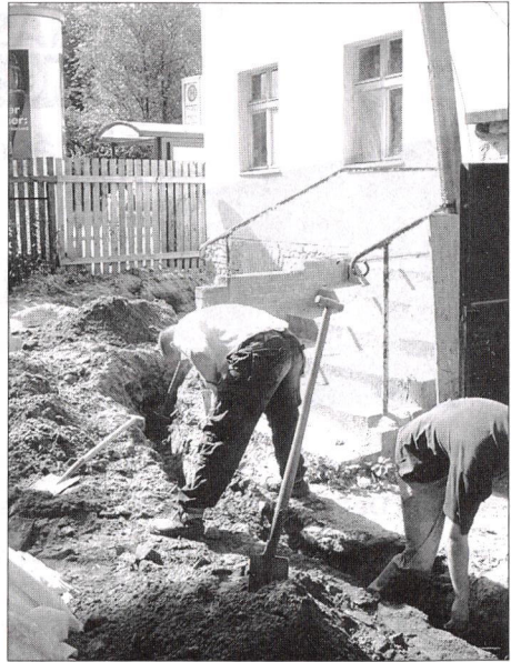
Verlegung des Blitzableiterbandes
