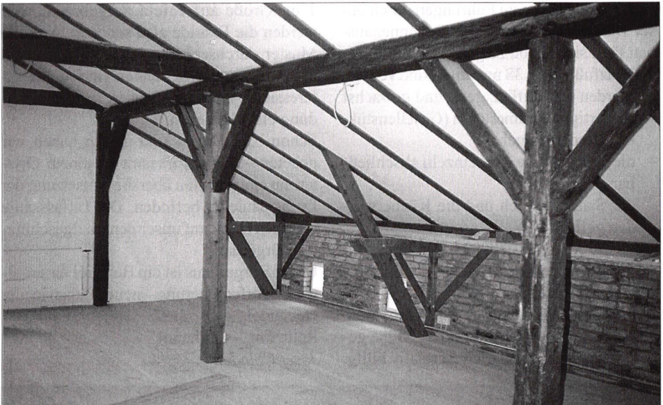
Die Dielenbretter im Dachgeschoss sind verlegt
