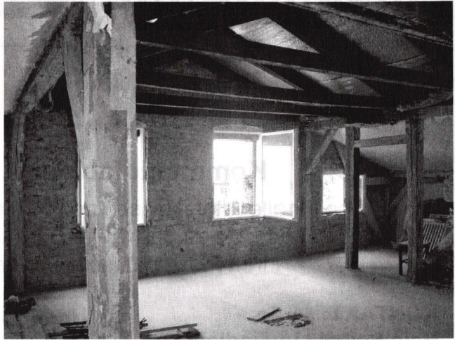
Das entkernte Dachgeschoss
