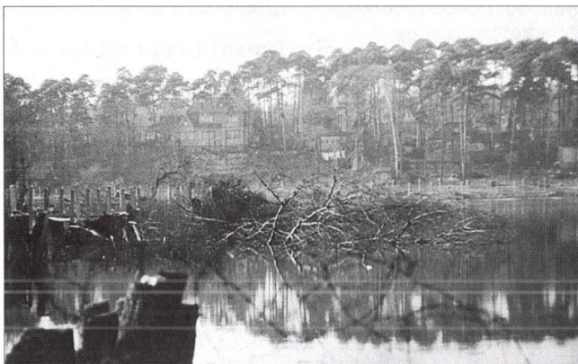
1961 Baumfällung für die Grenzanlagen am Groß Glienicker See
