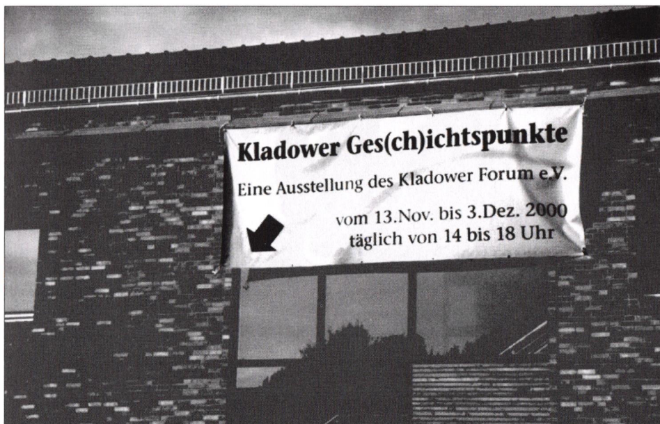
Hinweis zur Ausstellung am Gebäude Kladower Damm
