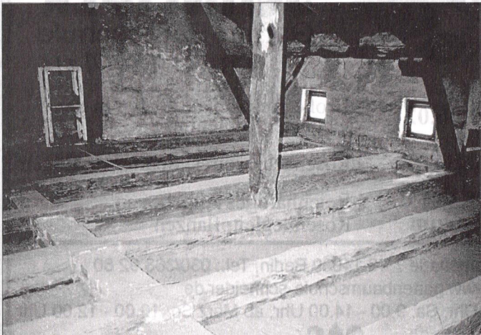
Freigelegte Balken im Obergeschoss
