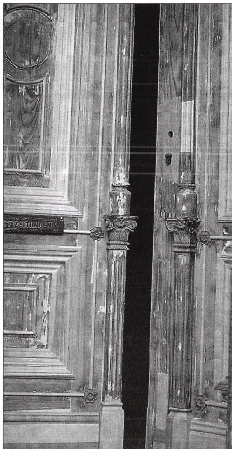
Die neue Eingangstür
