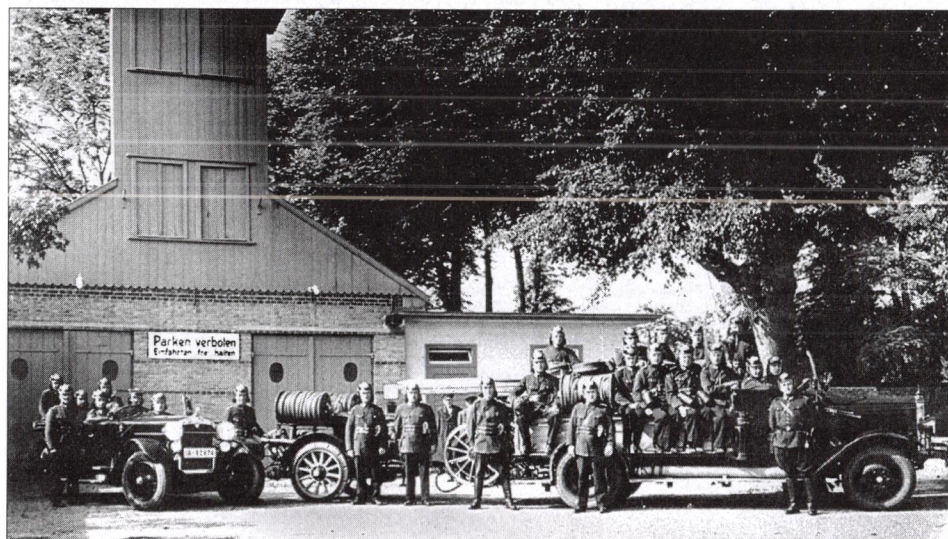
Spritzenhaus Sakrower Landstraße ca. 1925
