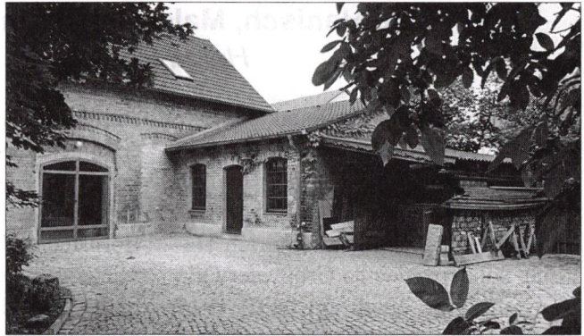
Die alte Schmiede an der Sakrower Landstraße 1989
