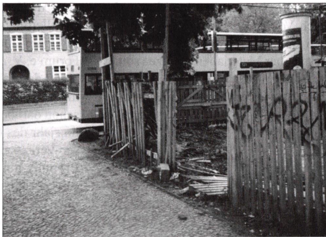
Demolierter Bauzaun am „Bürgerhaus“
